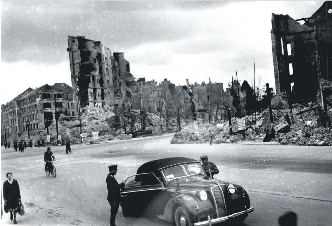
Разрушенные кварталы Берлина
